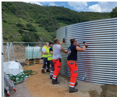
Kräfte des Deutschen Roten Kreuzes (DRK) bauen eine provisorische Kläranlage in der Gemeinde Mayschoß.
