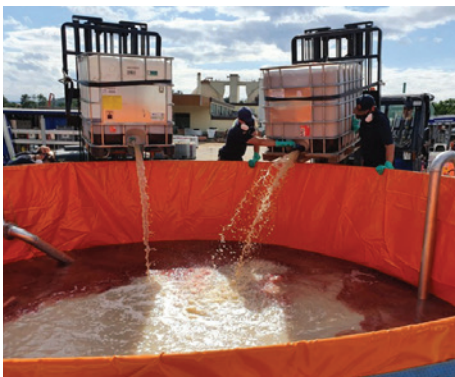
Fachgruppen Ölschaden vom THW reinigen kontaminiertes Wasser und pumpen beschädigte Heizöltanks in den Überflutungsgebieten leer.
