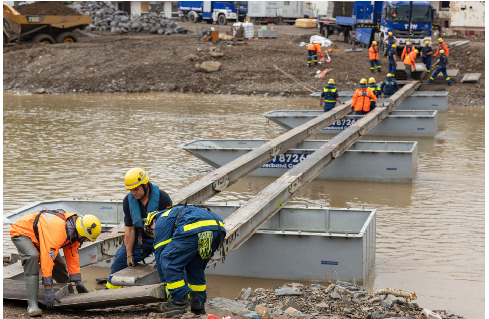
THW-Helferinnen und Helfer beim Bau einer provisorischen Brücke
